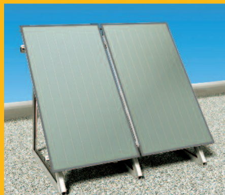
Montáž kolektoru na plochou střechu
